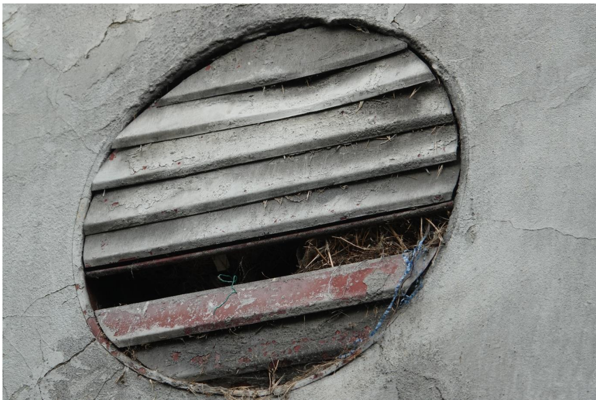
Fot. 7. Siedlisko (gniazdo) wróbla w uszkodzonym kanale wentylacyjnym budynku przy ul. G. Zapolskiej 3.
