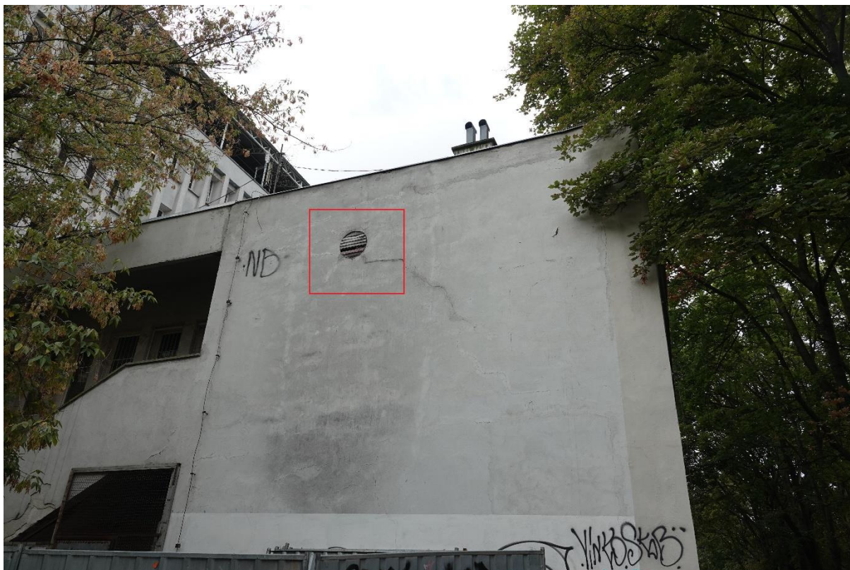
Fot. 6. Siedlisko (gniazdo) wróbla w uszkodzonym kanale wentylacyjnym budynku przy ul. G. Zapolskiej 3.
